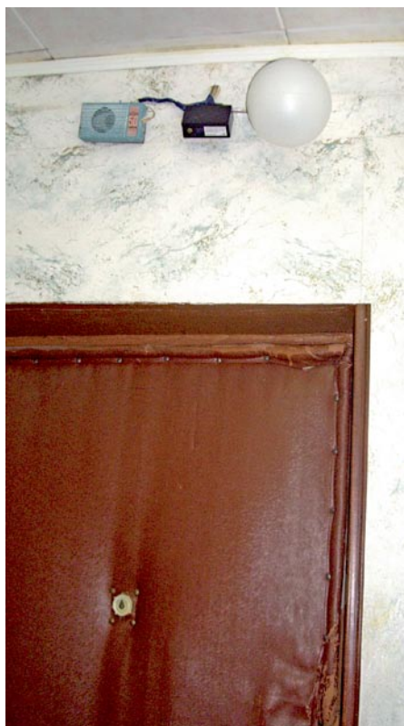
Рис. 7. Типовой вариант установки прибора (Дверь квартиры закрыта, лампа не горит)
